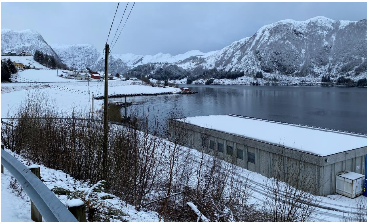
Figur 4-3: Nærast i bildet står bygninga til Orica som ligg nord i planområdet. Det nordlege påhogget til Stad skipstunnel ligg i Kjødepollen ca. 3 km lengre inne i fjorden. Foto: Norconsult Norge AS.
